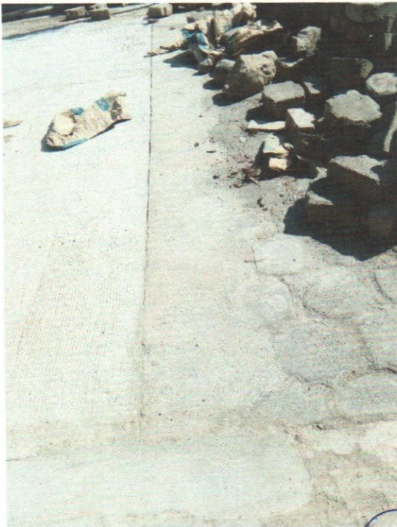
ANTISOL UTILIZADO PARA EL CURADO DEL CONCRETO
